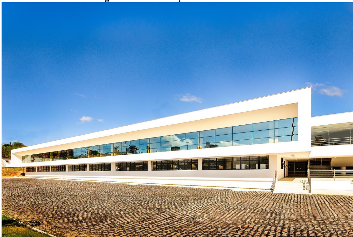
Figura 1. Fachada do prédio da Escola de Governo
